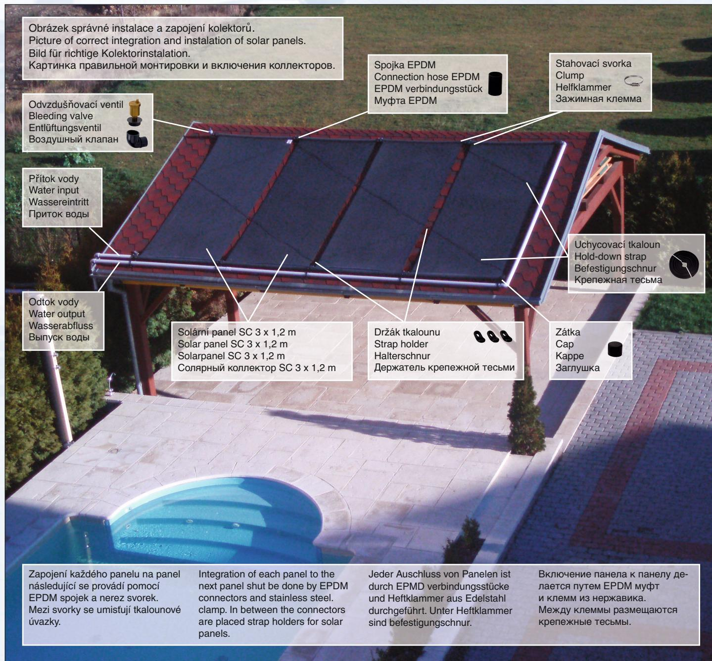
Systém solárního ohřevu je tvořen v řadě propojenými kolektory, napojenými do cirkulace vody v bazénu. Účinnost ohřevu je přímo úměrná celkové ploše instalovaných kolektorů. Doporučuje se, aby minimální plocha představovala cca 60 % vodní plochy bazénu (při hloubce 120–150 cm a použití vhodného zakrytí bazénu přes noc, případně v době, kdy není bazén používán). Zapojení těchto kolektorů se provádí přímo do cirkulačního okruhu (t.j. bez výměníku), takže účinnost ohřevu je velmi vysoká.
