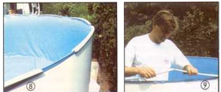
Handlauf fertig aufgesteckt ist, gehen Sie nochmals um das Becken herum und klopfen mit dem Handballen die einzelnen Teilstücke fest auf die Schwimmbeckenwand auf. Sind zwischen den Teilstücken Lücken entstanden, sollten Sie den Handlauf nochmals lösen und eng zusammenschieben. Das Endsegment sägen Sie entsprechend kürzer.
